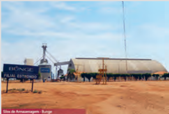
Silos de Armazenagem - Bunge
